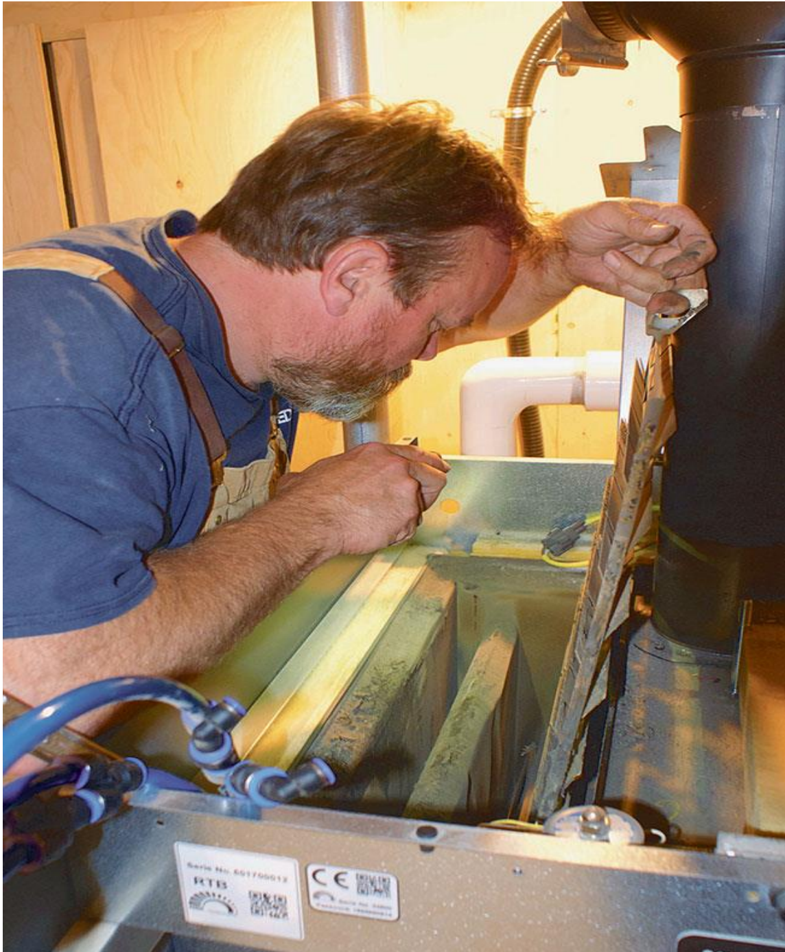
Stephen Hayes de THS Distribution examine une chaudière avec une lampe de poche. Photo gracieuseté de THS Distribution.
