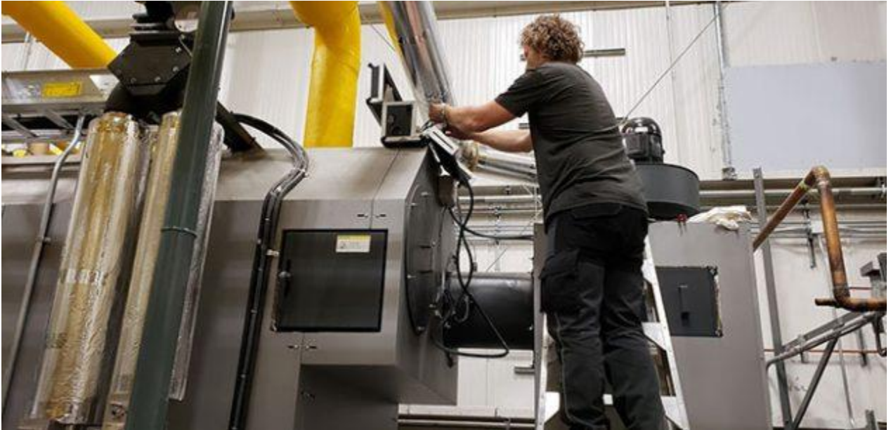
Nathaneal Dyck, technicien chez Fink Machine, teste les fumées sur une chaudière. Photo gracieuseté de Fink Machine.
